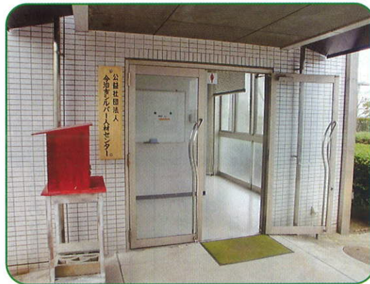
事務所建物の入口
